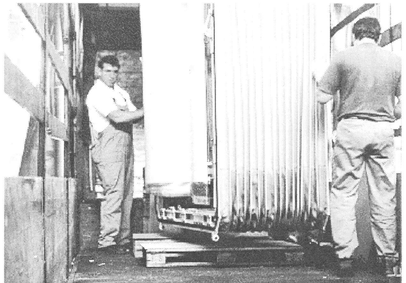
Zwei Mitarbeiter von Hübner positionieren den Übergang auf dem LKW.
